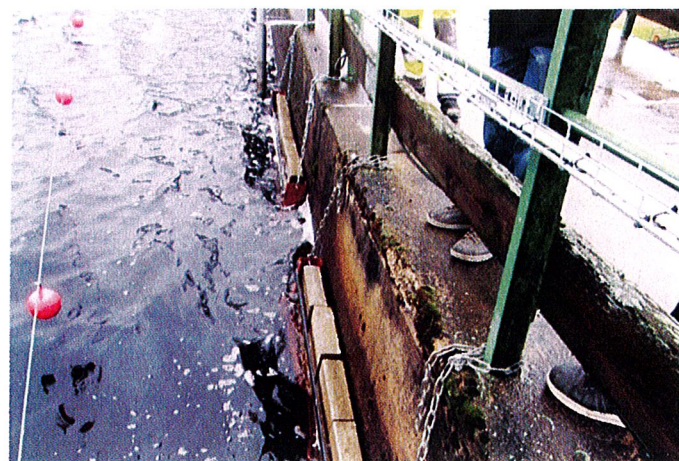
Figur 1: Paneler på dammens uppströmssida.
